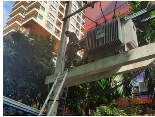
ดูแลตรวจสอบหม้อแปลงไฟฟ้า (การไฟฟ้า)
