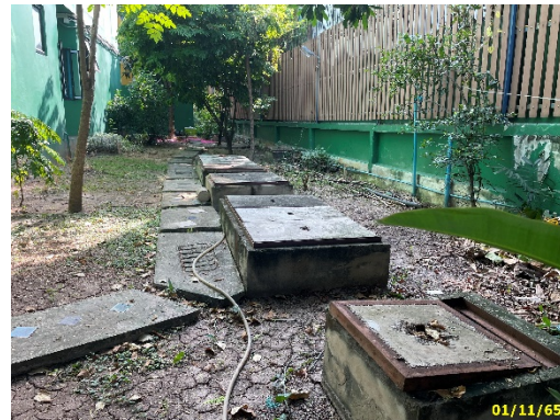
บ่อพักน้ำสุดท้ายก่อนระบายออกคลองสาธารณะ
